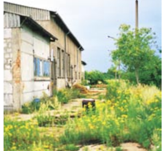
Auferstanden aus Ruinen: Kräutergarten Pommerland residiert in einem ehemaligen LPG-Gebäude.
